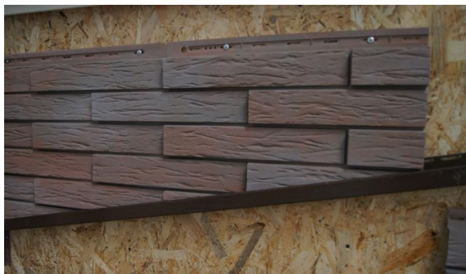
Использование J-трим ВН в качестве стартовой планки
